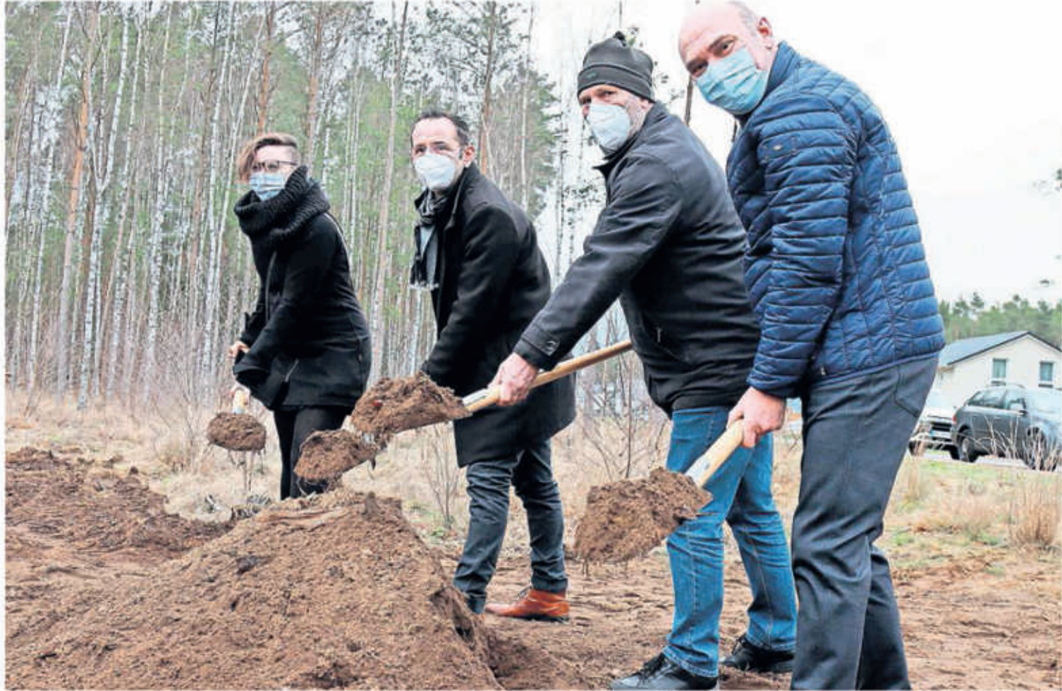
Anne Zscherper vom Potsdamer Planungsbüro S&P, Amtsdirektor Marko Köhler, Andreas Link (Vize-Bürgermeister Borkwalde) und Egbert Eska (Bürgermeister Borkwalde) läuten mit dem ersten Spatenstich den Bau der neuen Kita samt Gemeindesaal in Borkwalde ein. FOTO: JOHANNA UMINSKI
